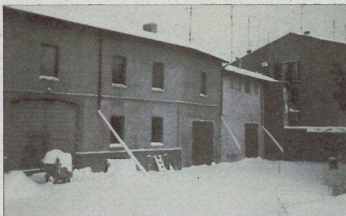
Nella serie di foto sono ripresi alcuni momenti dei lavori di ristrutturazione dei locali della nuova sede in via Bondiolo.
